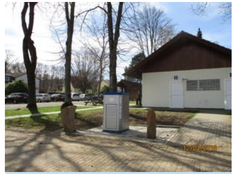
Sanitärstation, Foto: Bauverwaltung
