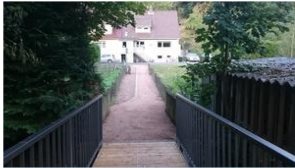
Neue Fußgängerbrücke, Foto Frau Menten, Buchenau
