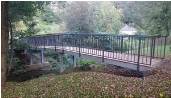
Neue Fußgängerbrücke; Foto Frau Menten, Buchenau
