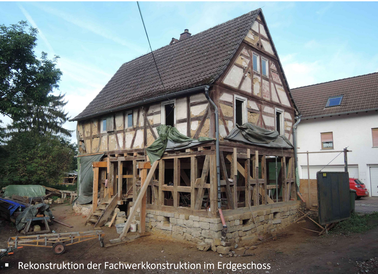
Das Fachwerkhaus nach der Sanierung des Fachwerks. Die nordöstliche Giebelseite, die man hier sieht, konnte fast komplett im originalen Zustand erhalten werden. Das gleiche gilt für das komplette erste Stockwerk und die Giebelwände des Dachgeschosses.
