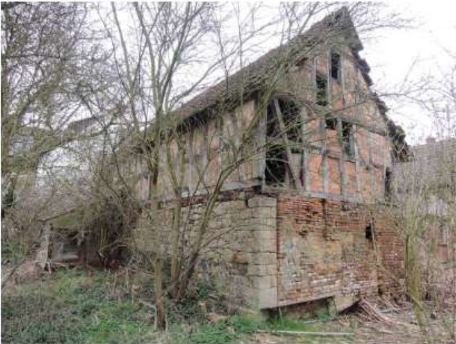
Die Südwestseite der Scheune.
