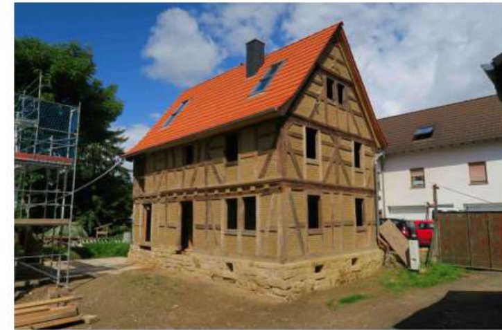
Das Fachwerkhaus nach der Sanierung des Fachwerks. Die nordöstliche Giebelseite, die man hier sieht, konnte fast komplett im originalen Zustand erhalten werden. Das gleiche gilt für das komplette erste Stockwerk und die Giebelwände des Dachgeschosses.
