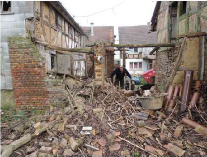
Der eingefallene Zwischenbau von der Gartenseite.
