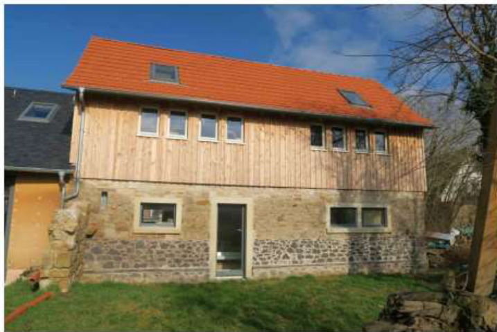
Die Gartenseite des sanierten Scheunengebäudes
