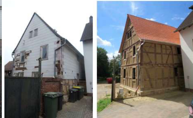
Die Ansicht vom Hoftor aus vor und nach der Fachwerksanierung.
